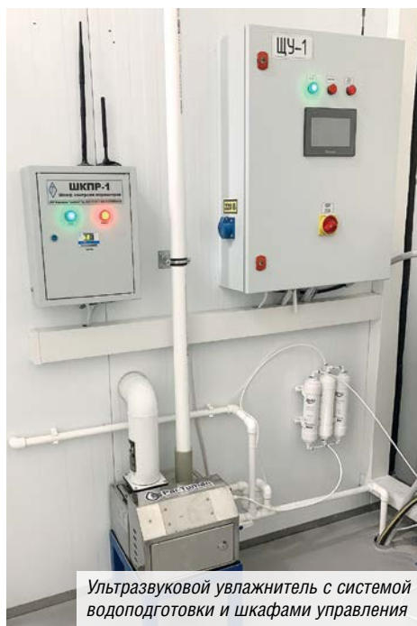
Камера постоянных климатических условий объёмом 92 м 3
