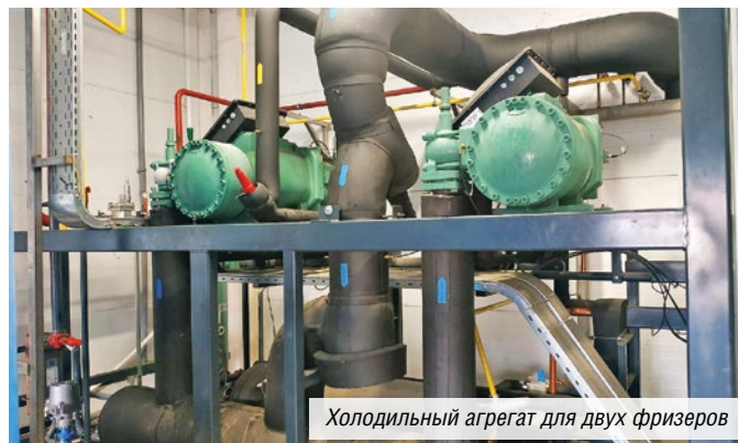
Установка охлаждения жидкости ФРИГОДИЗАЙН® с насосными агрегатами
