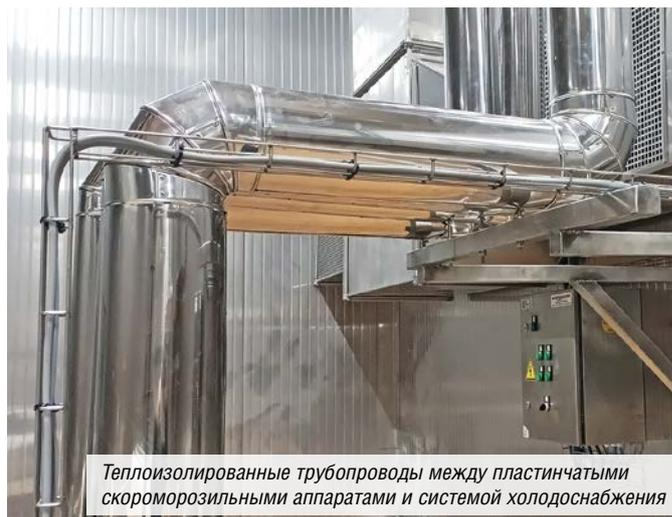
Теплоизолированные трубопроводы между пластинчатыми скороморозильными аппаратами и системой холодоснабжения
