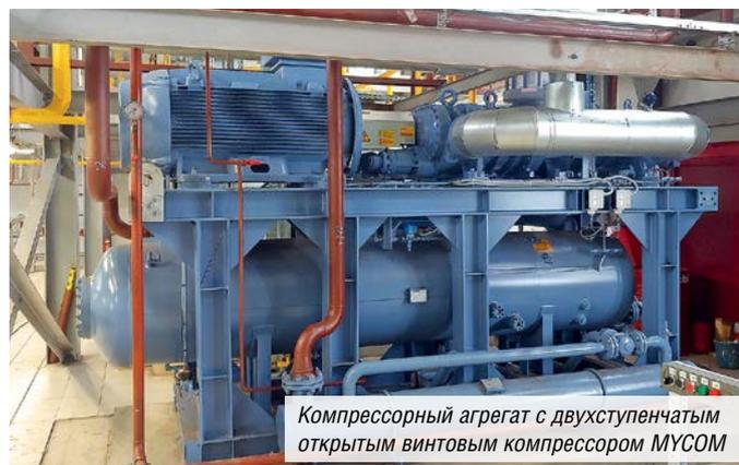
Компрессорный агрегат с двухступенчатым открытым винтовым компрессором MYCOM
