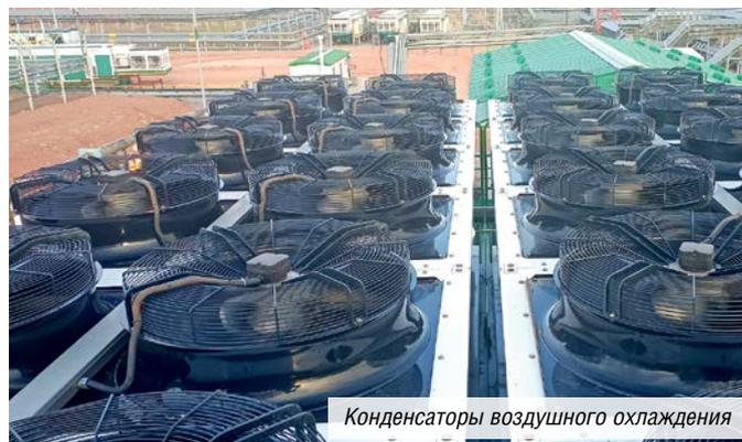
электродвигатель мощностью 710 кВт. Холодопроизводительность агрегата при температуре на выходе из испарителя  $-21^{\circ}\text{C}$  составляет 986 кВт. Вентиляторы конденсаторов суммарно потребляют почти 45 кВт.
