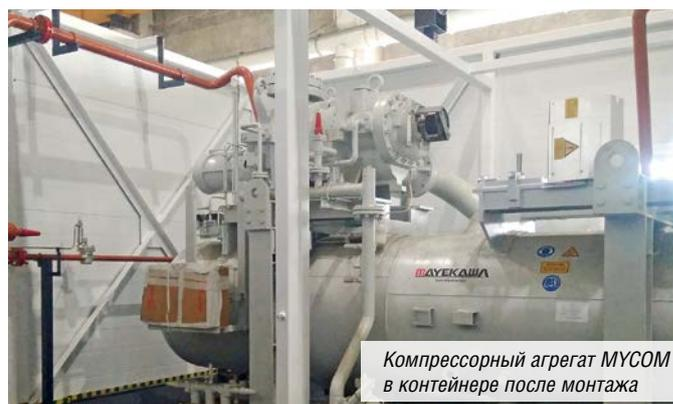
для крупногабаритной контейнерной мобильной установки подготовки попутного нефтяного газа производительностью 7 000 м<sup>3</sup>/ч. Мы также должны были поставить все комплектующие для этих систем, провести проверочные и пусконаладочные работы, обучить персонал контролю и техническому обслуживанию этой системы при её дальнейшей эксплуатации. Затем запустить это оборудование в эксплуатацию на одном из сибирских месторождений.
