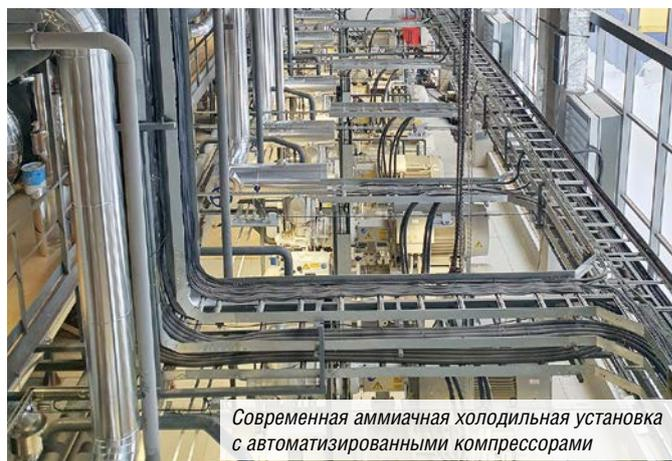
Современная аммиачная холодильная установка с автоматизированными компрессорами
