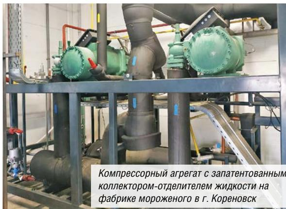
Компрессорный агрегат с запатентованным коллектором-отделителем жидкости на фабрике мороженого в г. Кореновск
