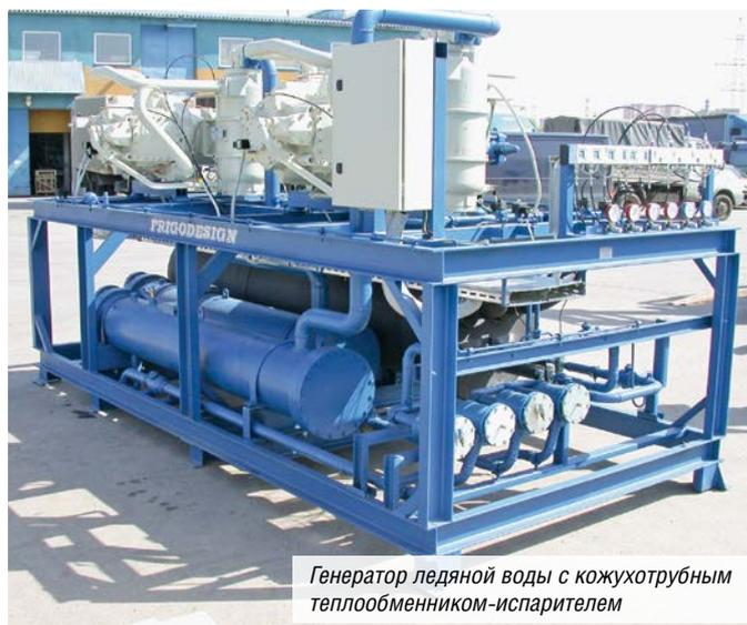
Генератор ледяной воды с кожухотрубным теплообменником-испарителем
