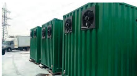
*Установка вентиляторов принудительной вентиляции контейнеров на производственной базе ООО «Фриготрейд»*
