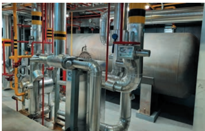
Рис. 3. Полуварной пластинчатый испаритель Danfoss SW в теплоизоляции
