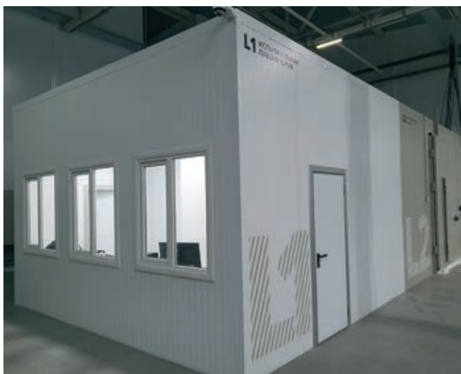
Пристроенное к камере помещение для размещения компьютеров, документации и персонала, обслуживающего испытания
