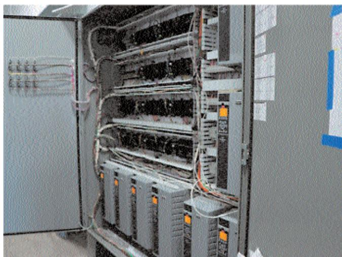
Выносная панель управления оттайкой с частотными регуляторами и «умными» контроллерами для воздухоохладителей.
