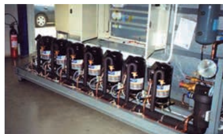
Рис. 2. Система возврата масла с OM3/OM4 TraxOil
