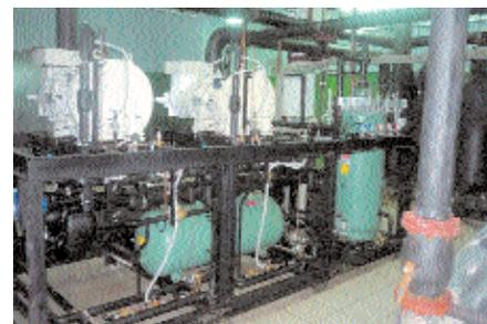
Установка охлаждения этиленгликоля на компрессорах J&E Hall, изготовленная компанией «Фригодизайн» для ОАО «Химфармзавод»
