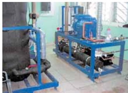
Установка охлаждения раствора этиленгликоля и гидромодуль, изготовленные ГК «Фригодизайн» для ОАО «Марбиофарм»
