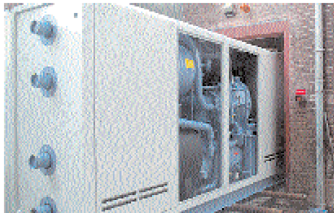
Холодильная машина (чиллер) BluAstrum в шумозащитном кожухе проходит в дверной проем
